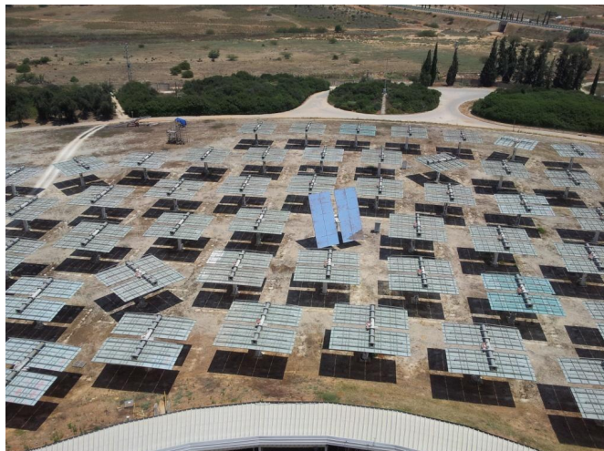
Fig. 27. Câmpul de heliostate de la Institutul de Știință Weizmann din Rehovot, Israel.
