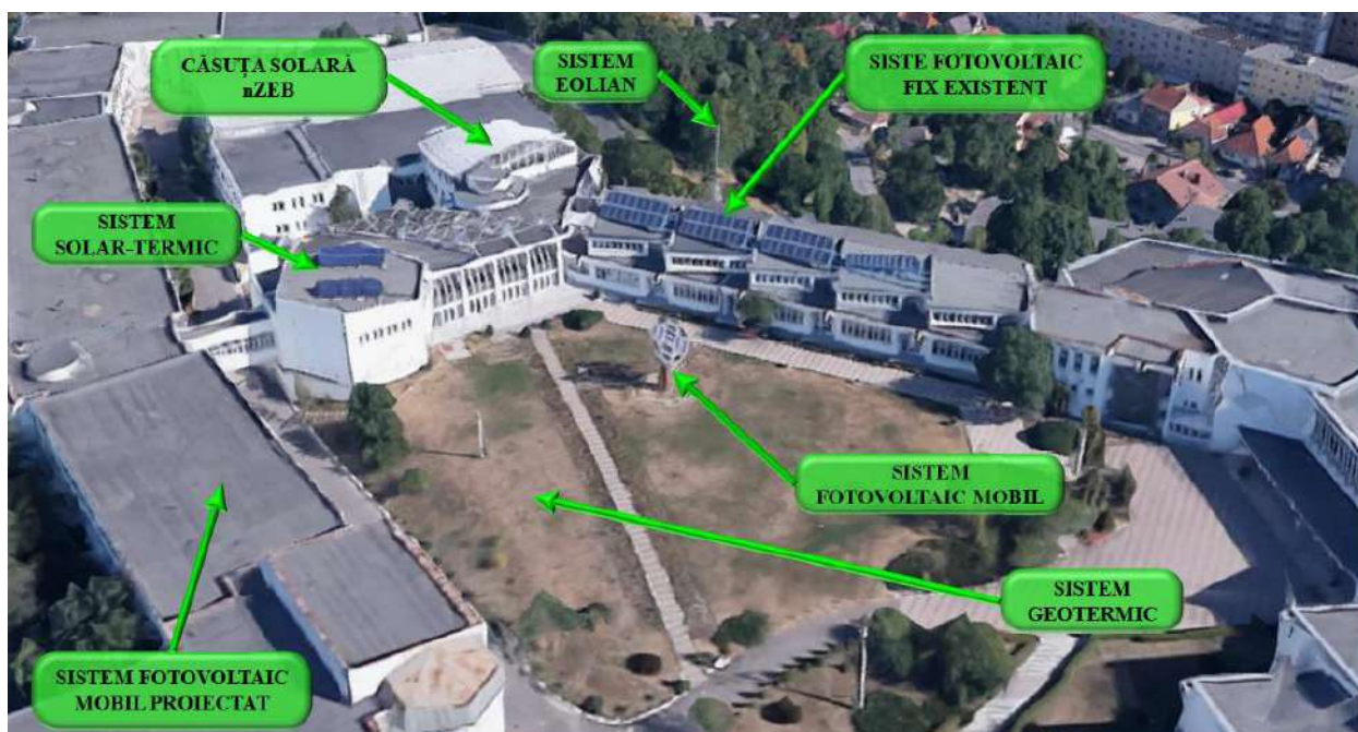
Fig. 1.19 Propunere de amplasare a sistemului fotovoltaic mobil pe terasa corpului G de pe Colina Universității Transilvania din Brașov [Moldovan et al, 2010]
