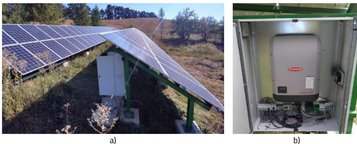
Fig. II.15 Sisteme fotovoltaice on-grid de 33,6 kW instalate în Baza Didactică Multidisciplinară Sânpetru a Universității Transilvania din Brașov
