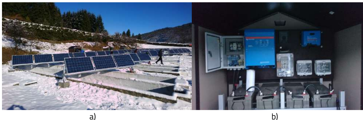
Fig. II.12 Sistem fotovoltaic off-grid de 6 kW în cadrul Bazei Didactice Multidisciplinare Gârcin a Universității Transilvania din Brașov
