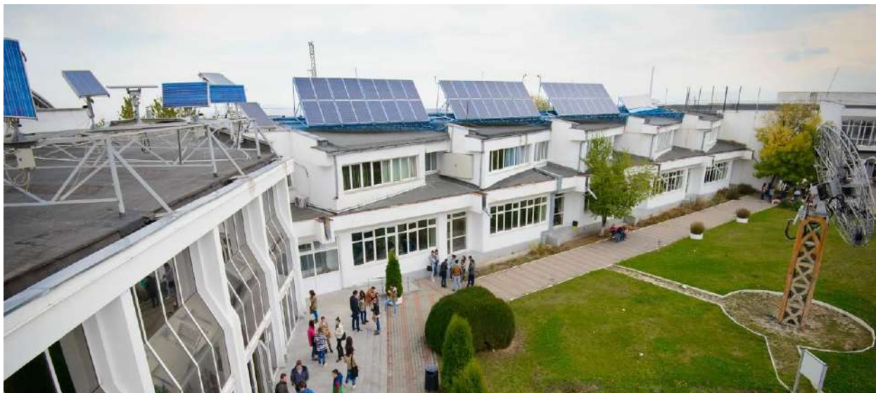
Fig. 1.18 Sistem fotovoltaic instalat pe corpul D de pe Colina Universității Transilvania din Brașov
