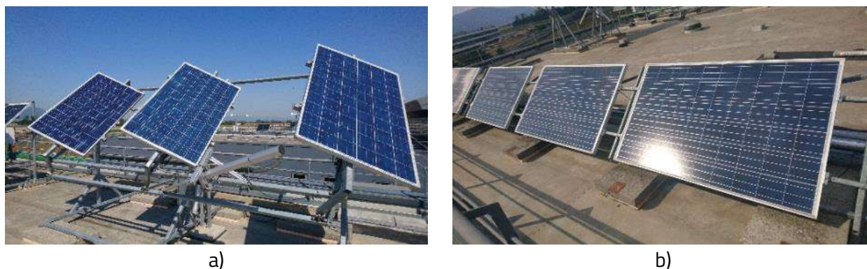
Fig. 4.59 Sistem de orientare pseudo-ecuatorial pentru trei module fotovoltaice (a) și platformă fixă cu trei module fotovoltaice similare (b) instalate pe acoperișul clădirii L7 din ICDT [Moldovan et al, 2023b]
