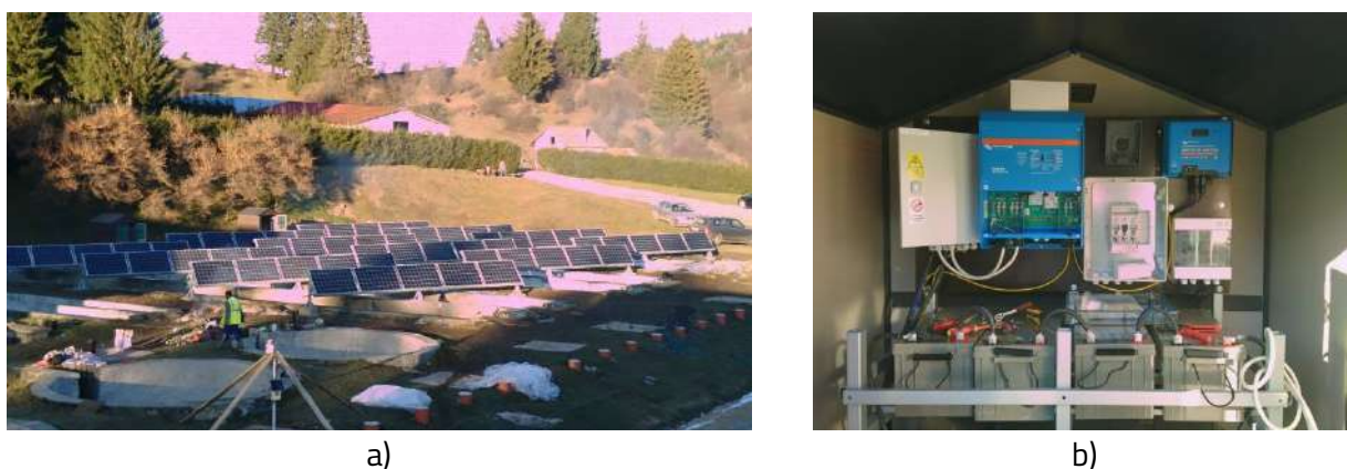
Fig. II.11 Sistem fotovoltaic off-grid de 15 kW în cadrul Bazei Didactice Multidisciplinare Gârcin a Universității Transilvania din Brașov
