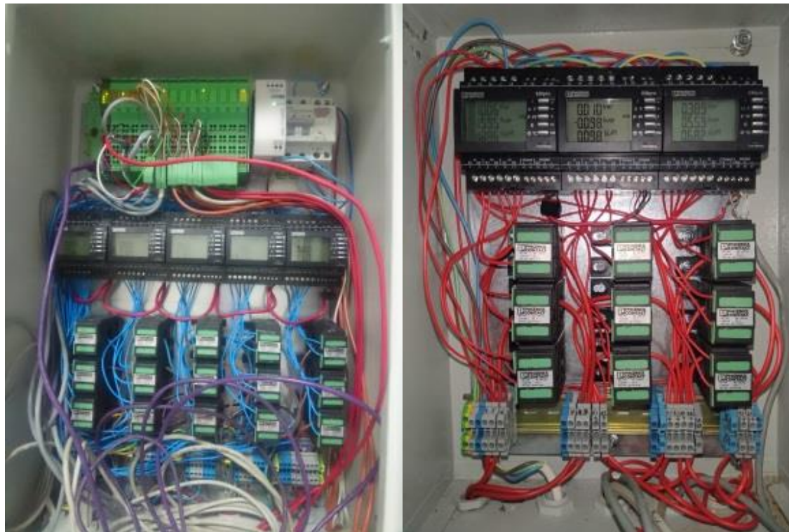
Automat programabil monitorizare și contoare energie electrică
