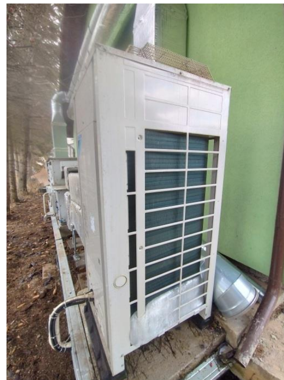
Pompă de căldură aer-aer Ph=16kW, Pc=14kW
