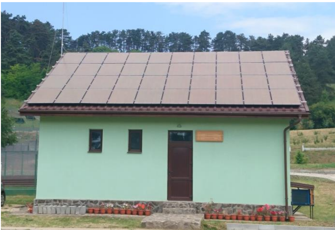
40 de module fotovoltaice de 250W
