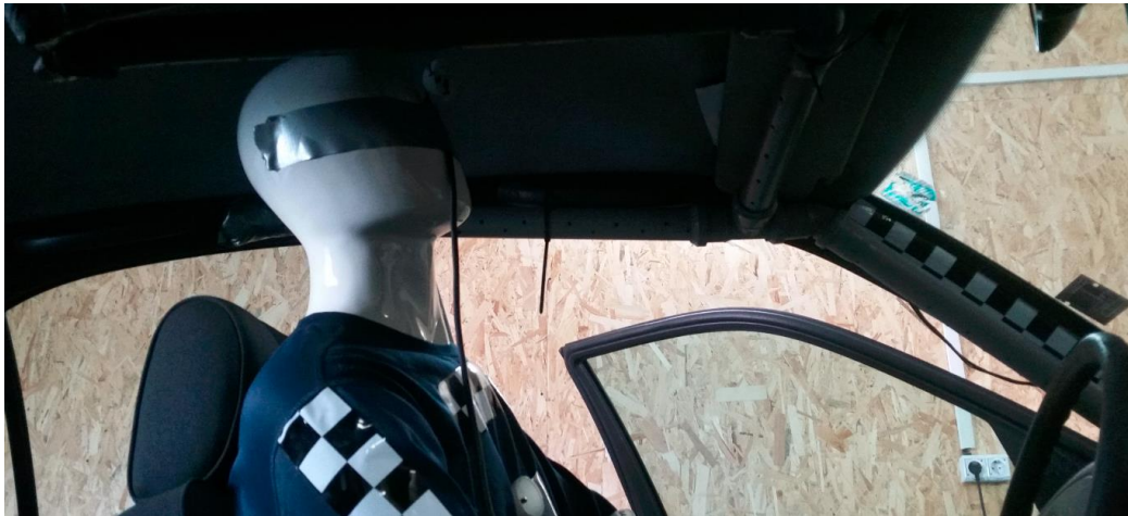
Fig. 60 Tubulatura perdelei cu jeturi de aer circulare turbulente montata pe plafon
