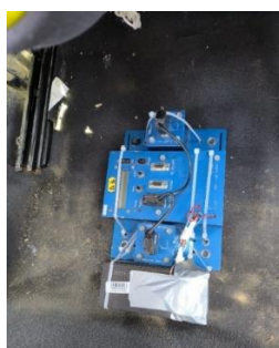
Figura 5.9 Zona de instalare a accelerometrului PicDAQ 4
